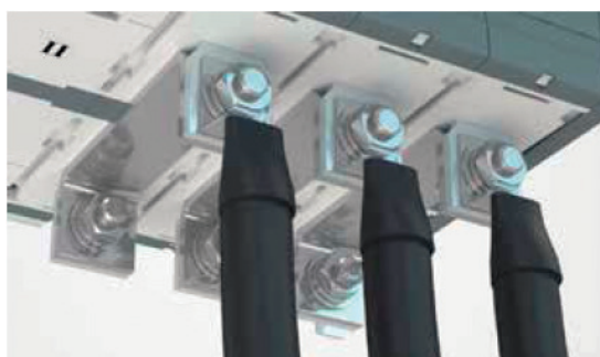
Barras de puente
