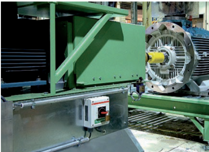
Los Seccionadores de Seguridad pueden ser bloqueados por cándado en la posición OFF.
